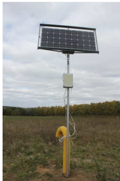
Рис.9. Питание от солнечной батареи
